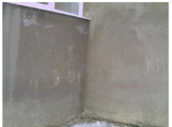
Рис.П65. Потери заделку стен
