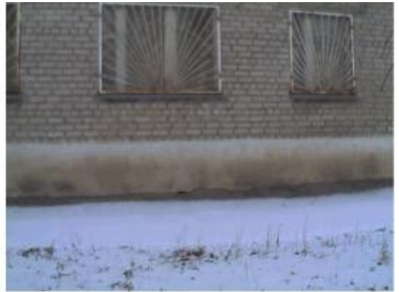
Рис.П58. Потери через фундамент и стены от приборов отопления
