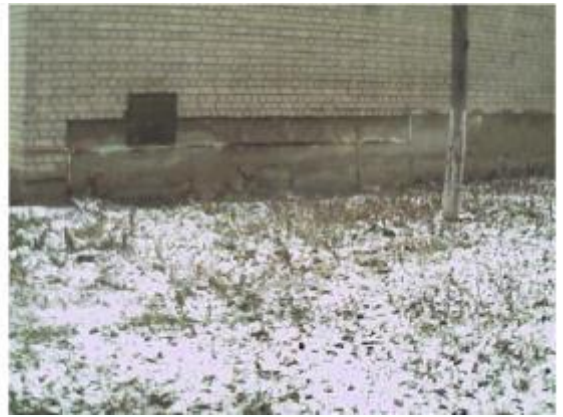
Рис. П8. Потери тепла через цоколь здания
