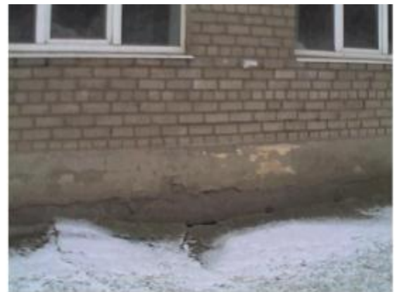
Рис.П49. Потери через трещины в фундаменте
