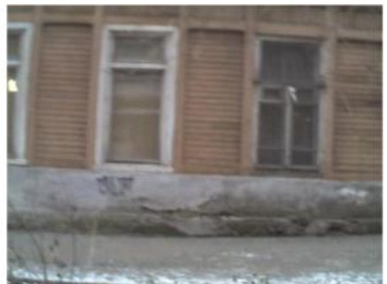
Рис.П86. Потери через трещины фундамента
