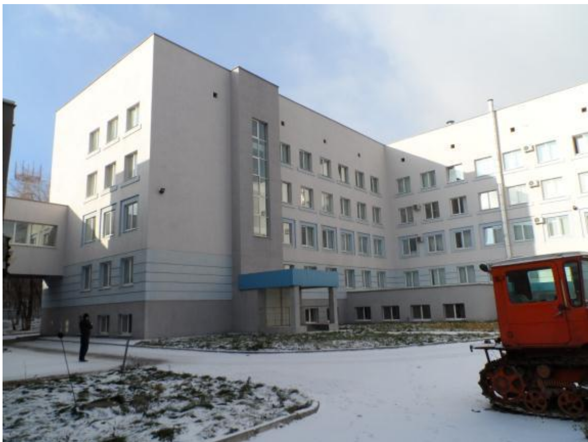
Рис.4. Здание учебного корпуса литеры «Е»
