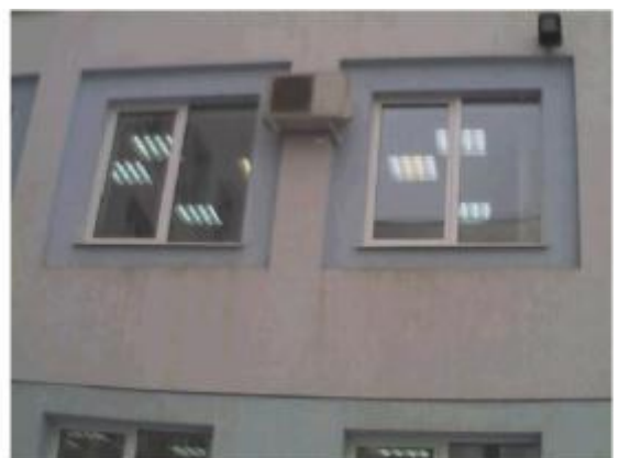
Рис.П40. Потери оконные откосы
