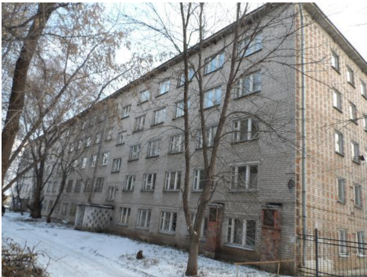
Рис.6. Нежилое здание литеры «П»
