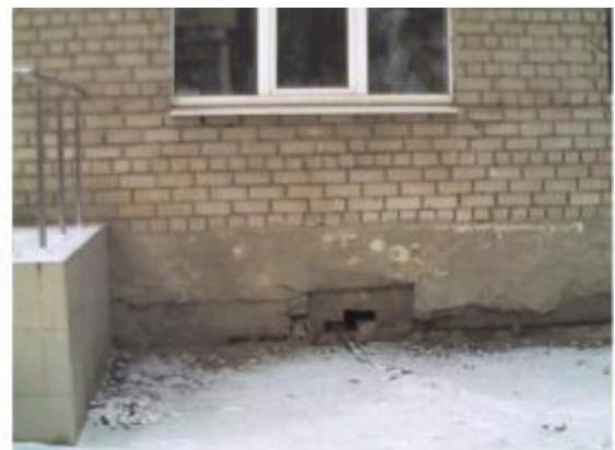
Рис.П44. Потери через отверстие в подвал (фундамент)
