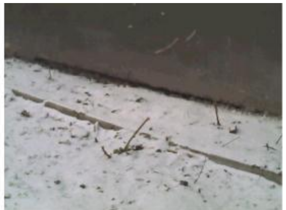
Рис.П64. Потери через трещины фундамента
