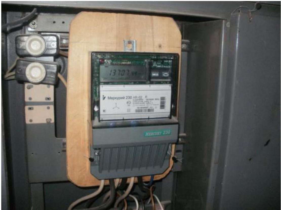
Рис.21. Главный распределительный щит лабораторного корпуса №1 на ул. Галактионовской
