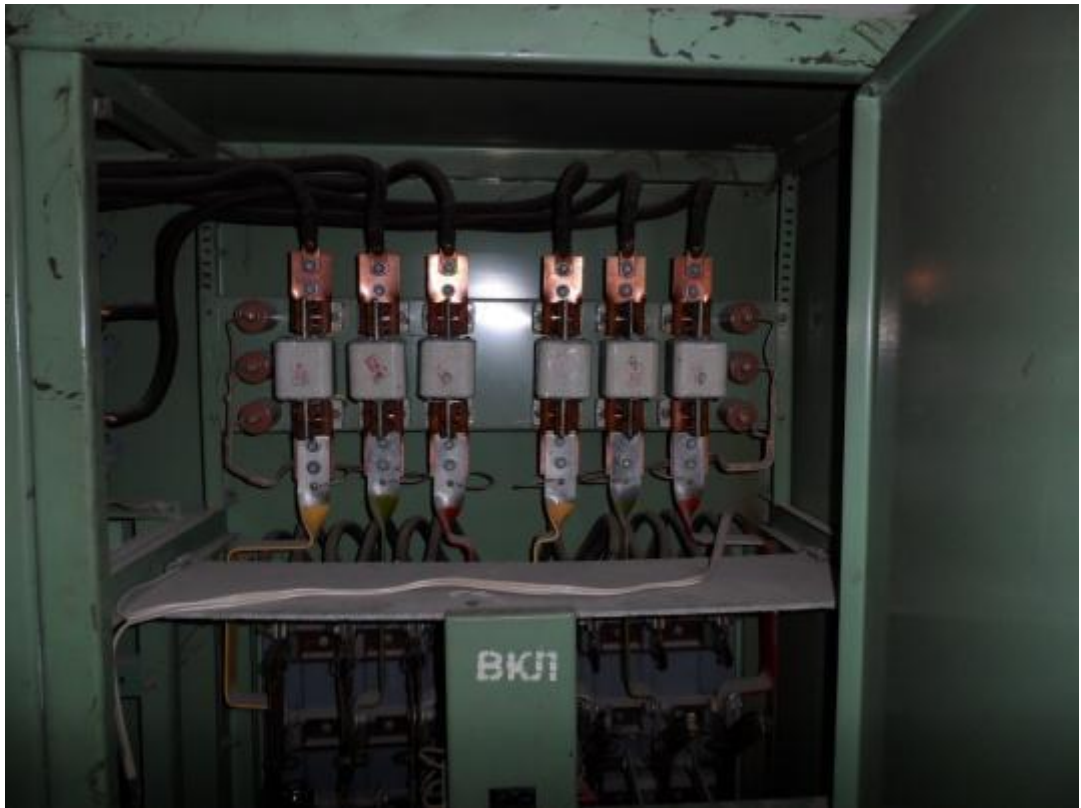
Рис.16. Главный распределительный щиткорпус №1 литера «А»
