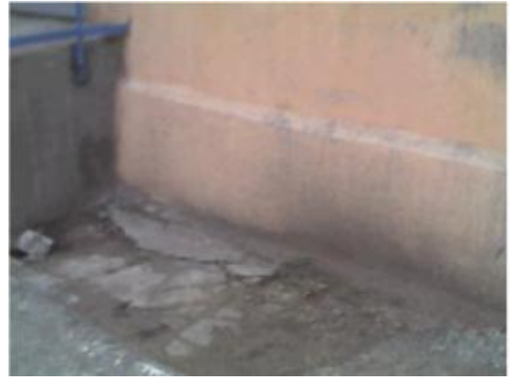
Рис.П93. Потери через некачественную заделку фундамента
