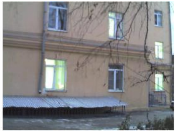
Рис.П90. Потери через вход в подвал
