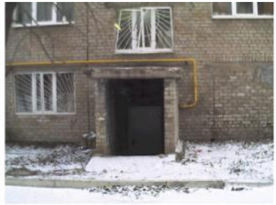
Рис.П51. Потери через дверной проем и подвал
