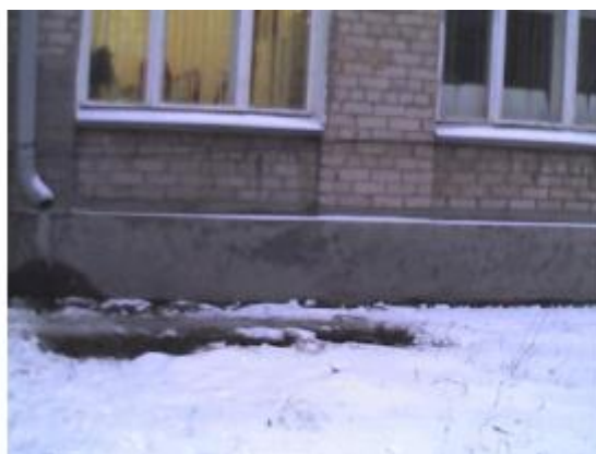
Рис.П101. Потери через стены от приборов отопления и цоколь здания
