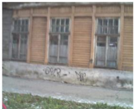
Рис.П85. Потери через фундамент и оконные конструкции
