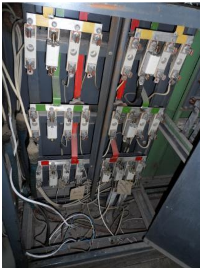
Рис.18. Главный распределительный щит общежития №4 литера «Г»
