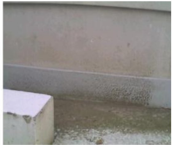
Рис.П13. Потери через цоколь (вход в подвал)
