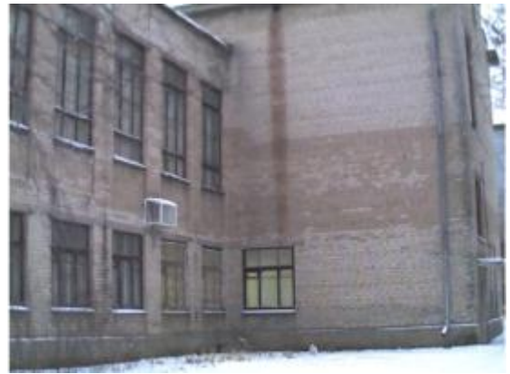
Рис.П111. Потери через стык стен и открытые окна
