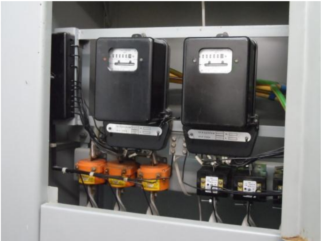
Рис.20. Главный распределительный щит литера «П»
