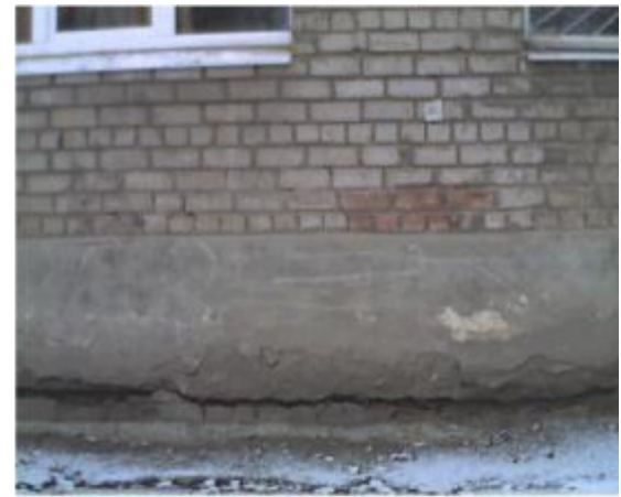
Рис.П46. Потери через трещины в фундаменте
