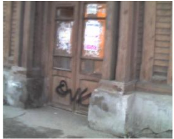
Рис.П84. Потери через дверь и цоколь здания
