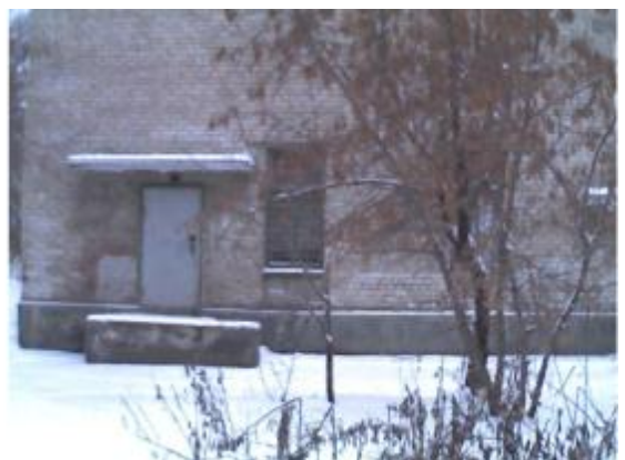
Рис.П104. Потери через неплотности двери
