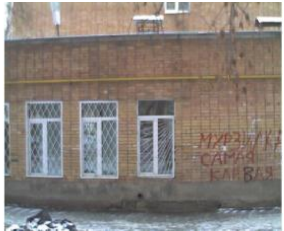
Рис.П16. Потери тепла через цоколь здания (а)
