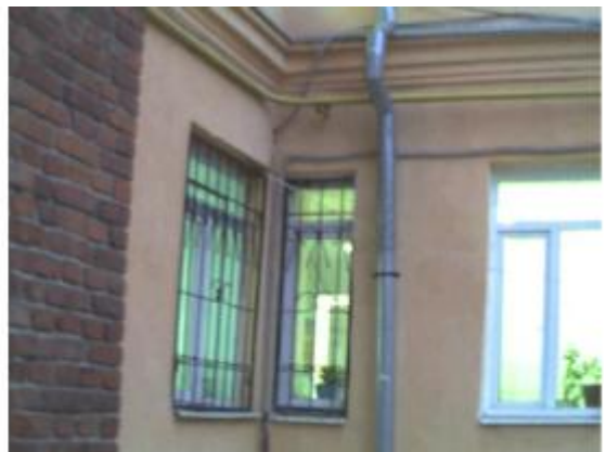
Рис.П92. Потери через стык стен
