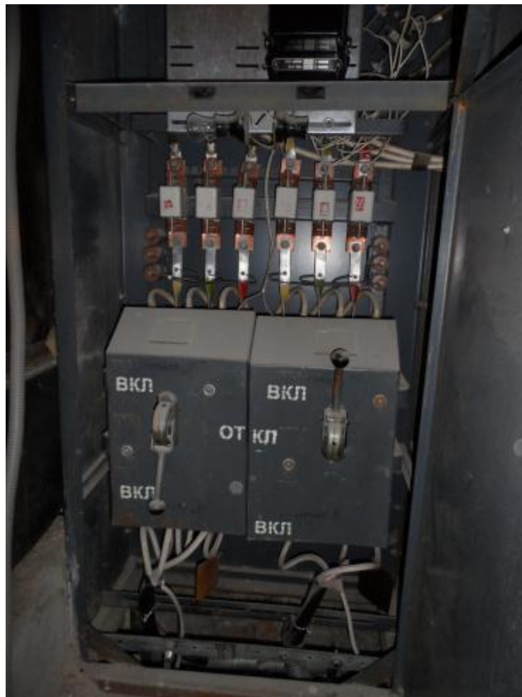
Рис.17. Главный распределительный щит корпус №1 литера «В»
