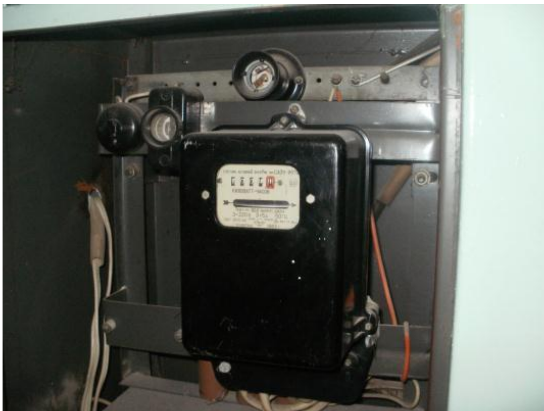
Рис.22. Главный распределительный щит лабораторного корпуса №2 на ул. Галактионовской
